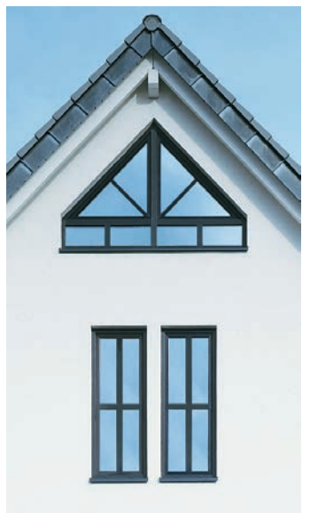
A függőleges osztóbordákkal az ablakfelület finom, elegáns tagolása érhető el.
